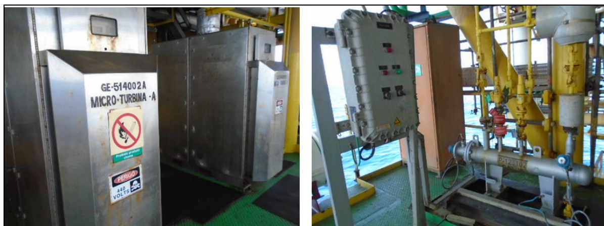
Figura I.3-12 - Microturbinas e aquecedor de gás para microturbinas.
